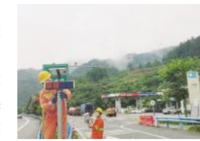
●及时抢修机电设施。
