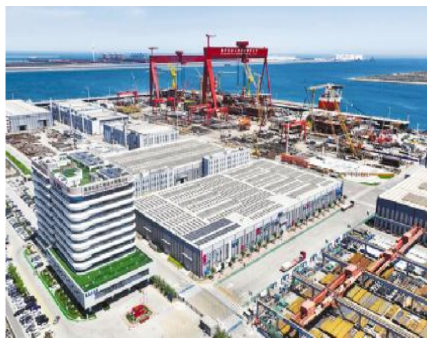
●位于天津港保税区的海油工程天津智能制造基地
