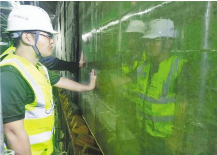
● 岩壁梁开挖平整度达到镜面效果。
