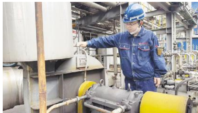
●姜万里在检查尾气引风机内部积液情况。
