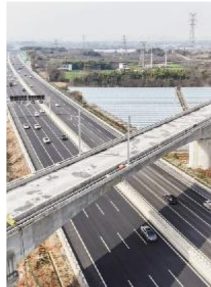
●2月10日,成渝中线高铁四川段桥梁建设全部完成。这是当日在成都拍摄的成渝中线高铁最长桥梁龙泉特大桥跨沪蓉高速公路。
