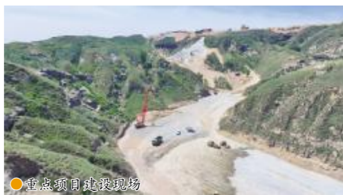
● 重点项目施工现场
