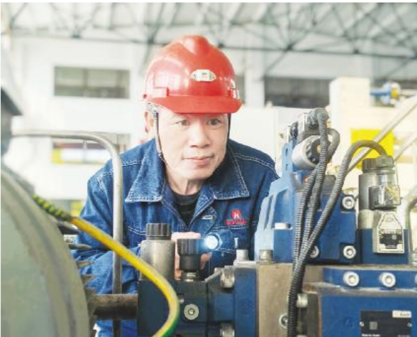
● 张国庆在巡查加压过滤机设备运行。
