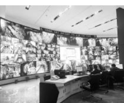
细节彰显标准。以井下综掘工作面为例，摄像头安装严格遵循“迎头新面居中、人员清晰可见”要求。在2307工作面，摄像头全面覆盖，实时监控掘进进度，又能精准捕捉TO、T1甲烷传感器附近数据变化。这背后是严格的流程管控：使用单位提前3天提交申请，机电部严把防爆隐患排查，调度指挥中心分配IP地址，开展网络调试，确保每一路视频信号清晰、传输稳定、定位精准。
