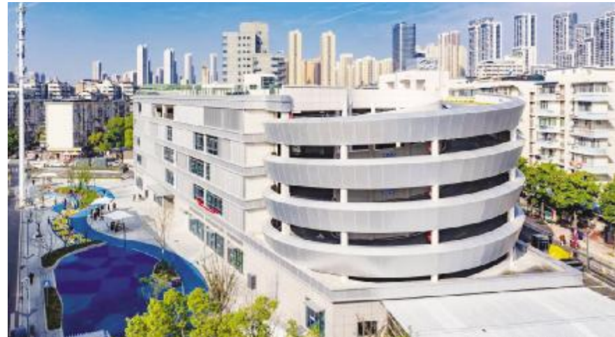
● 湖北省武汉市汉阳区知音东苑小区利用小区空地新建的综合停车楼。
