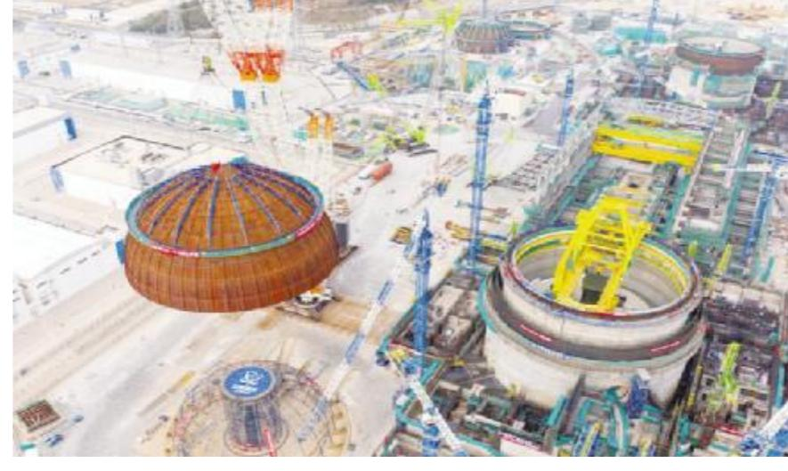
据中新网消息,2月4日,华龙一号批量化建设中,中核集团旗下中国核电投资控股的漳州核电3号机组内穹顶顺利吊装成功。
