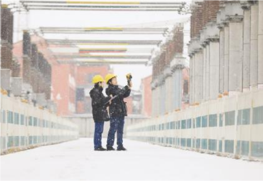
● 1 月 19 日,在河南省焦作市温县 220 千伏孝乡变电站,工作人员利用红外测温仪对供电设备进行测温测负。 新华社发 黄福兴 摄
