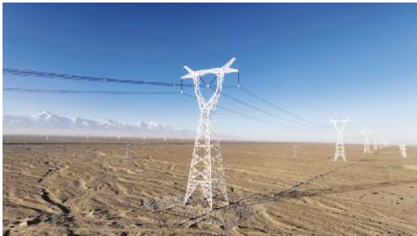
● 民丰—且末 750 千伏线路输变电工程线路
