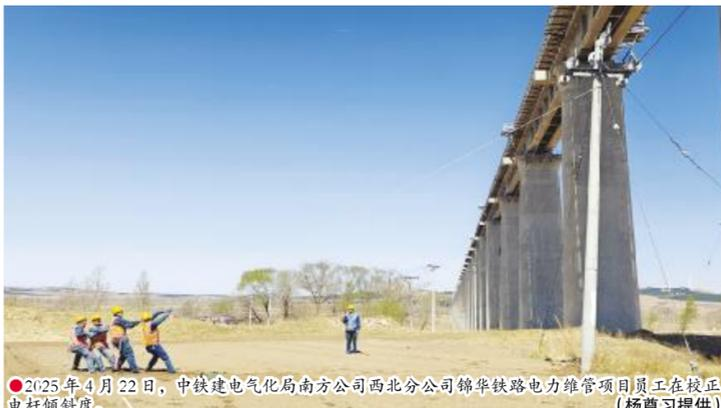
● 2025 年 4 月 22 日,中铁建电气化局南方公司西北分公司锦华铁路电力维管项目员工在校正电杆倾斜度。(杨尊习提供)
