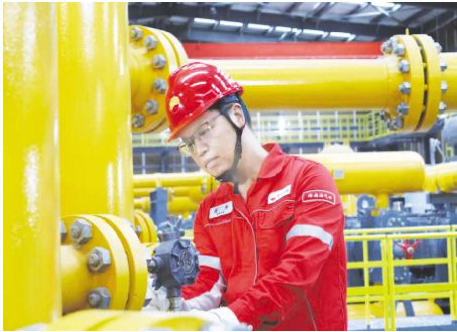
● 图为蒋伟在生产现场更换压缩机分离器液位仪表
