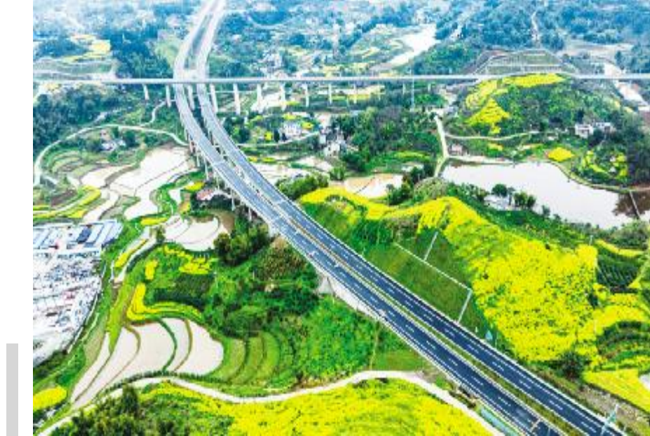
● 巨能集团承建的永津高速公路孔家桥大桥
