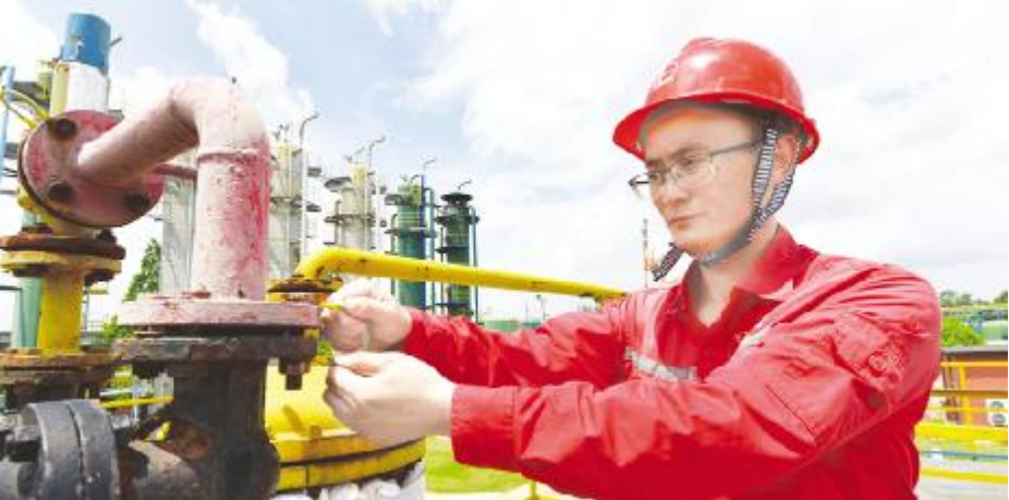
● 7 月 1 日,俸跃文在双河联合站检查两相分离器静电跨接线是否松动。
