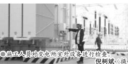
施工人员对变电所室外设备进行检修。 倪树伟/摄
