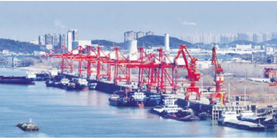
● 在安徽芜湖港朱家桥港区国际集装箱码头，货轮在进行集装箱装卸业务。（无人机照片）
