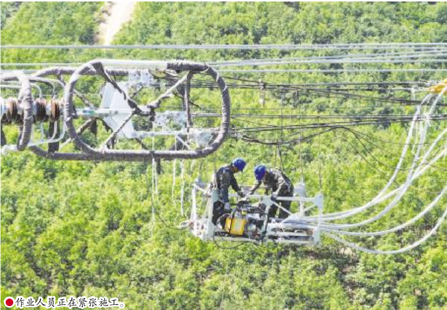
● 作业人员正在紧张施工。
