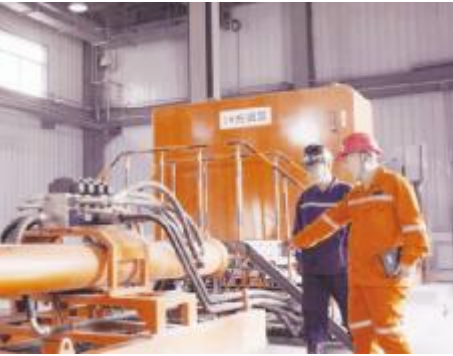
● 膏体充填系统定期安全检查。
