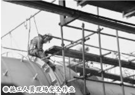
●施工人员现场安全作业
