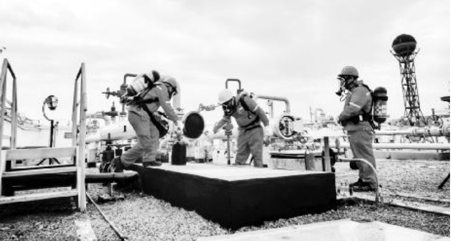
●图为操作员工对收发球筒进行清理。
