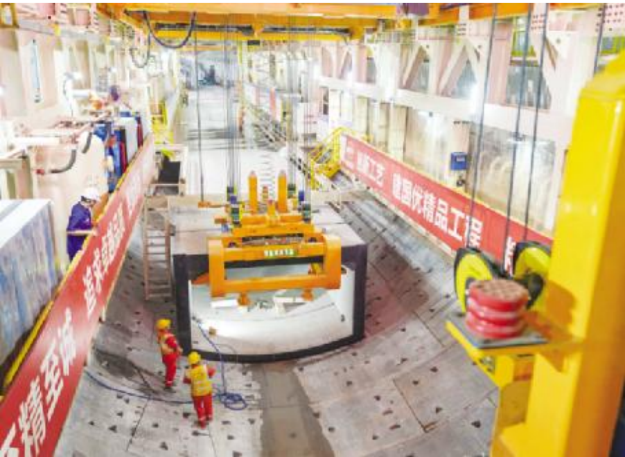
●4月18日,工人在位于四川省成都市的成渝中线高铁蜀安隧道进行施工作业。 王曦 摄
