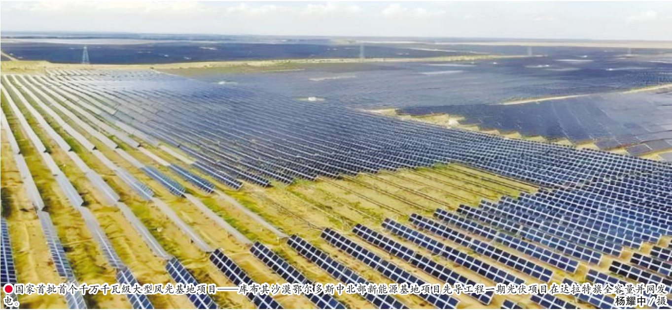
●国家首批首个千万千瓦级大型风光基地项目——库布其沙漠鄂尔多斯中北部新能源基地项目先导工程一期光伏项目在达拉特旗全容量并网发电。杨耀中/摄
