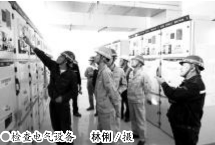
●检查电气设备 林俐/摄
