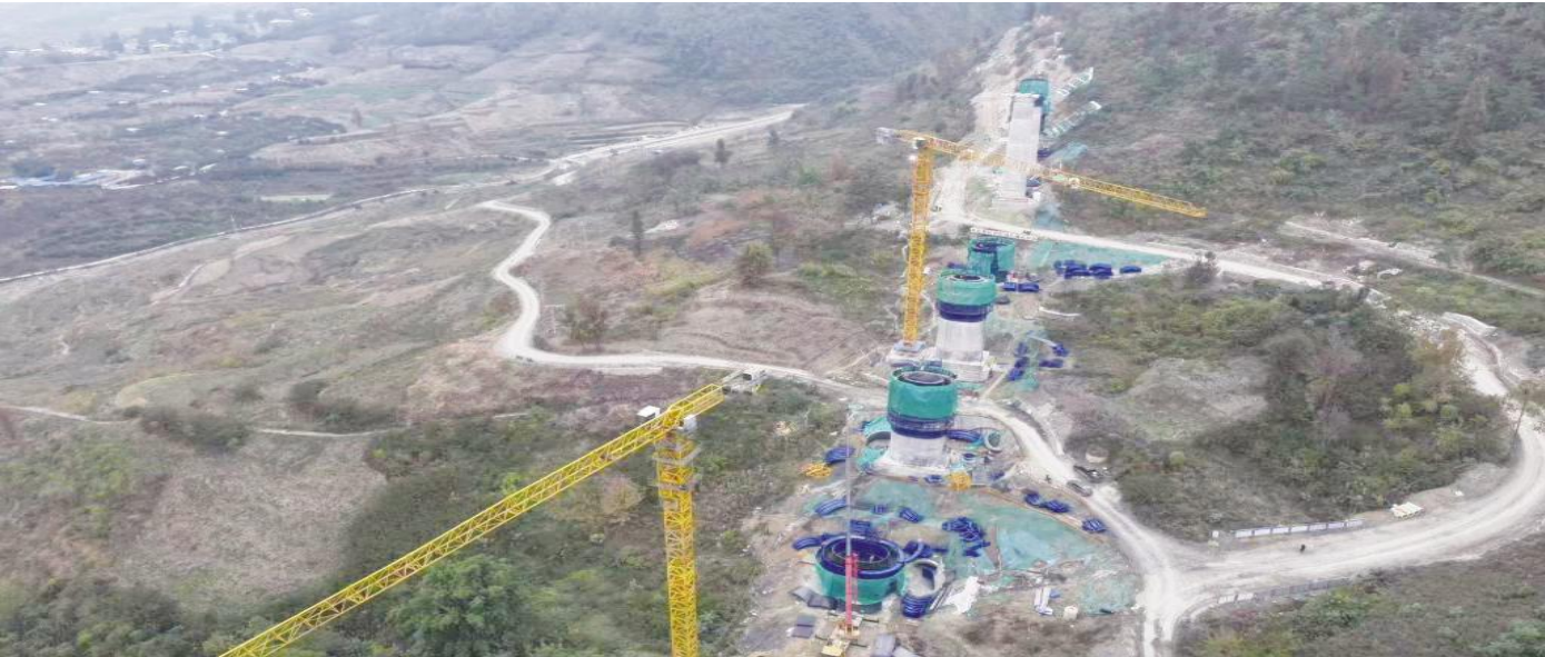
●图为羊架河特大桥施工现场。
