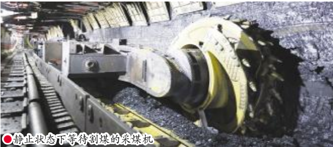
●静止状态下等待割煤的采煤机
