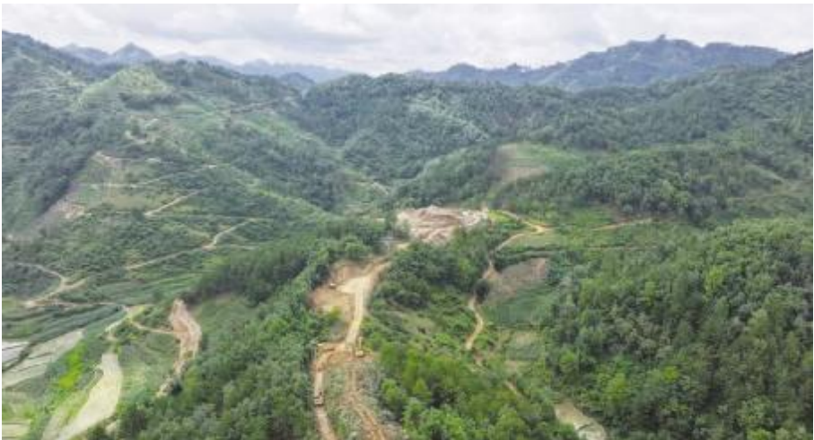
蜿蜒在山岭间的黄百铁路施工便道
