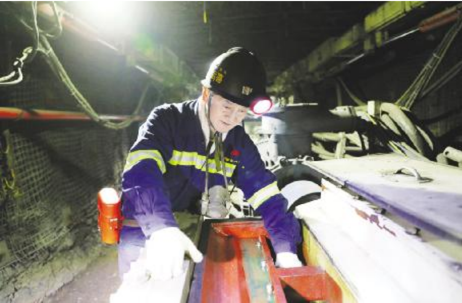
穆运喜正在检修液压泵站
