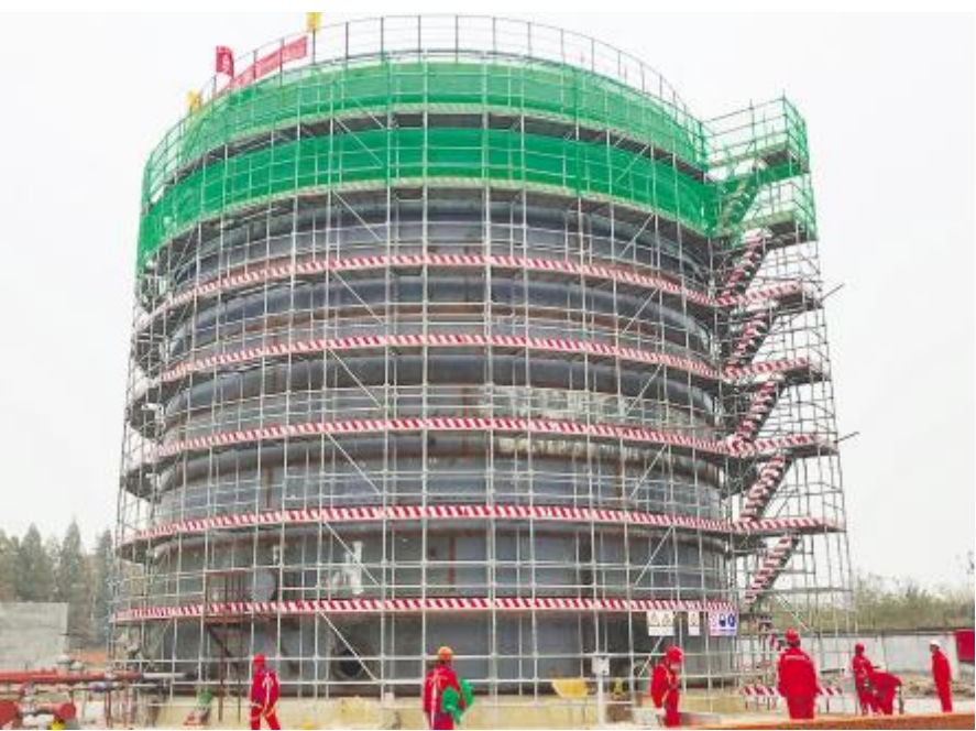
●河南油建在罐体外采用承插型盘扣式脚手架搭设技术,提高脚手架作业的安全性和规范性。图为施工人员正在做脚手架搭设准备工作。
