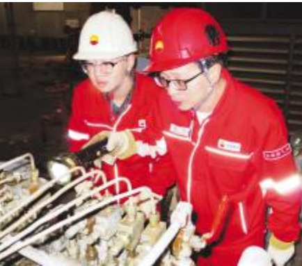
●焦龙(右)给来站实习的大学生讲解注油器原理。
