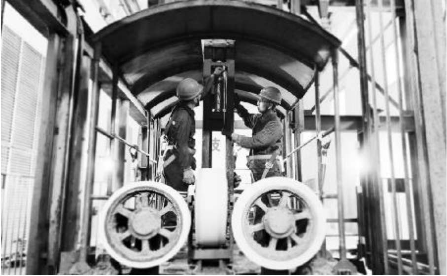
● 图为矿井重点督办工作施工现场。
