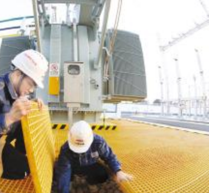
●2024 年 11 月 6 日,项目部技术人员在杭衢高铁衢州西牵引变电所,检查变压器油池网格栅。郑传海/摄
