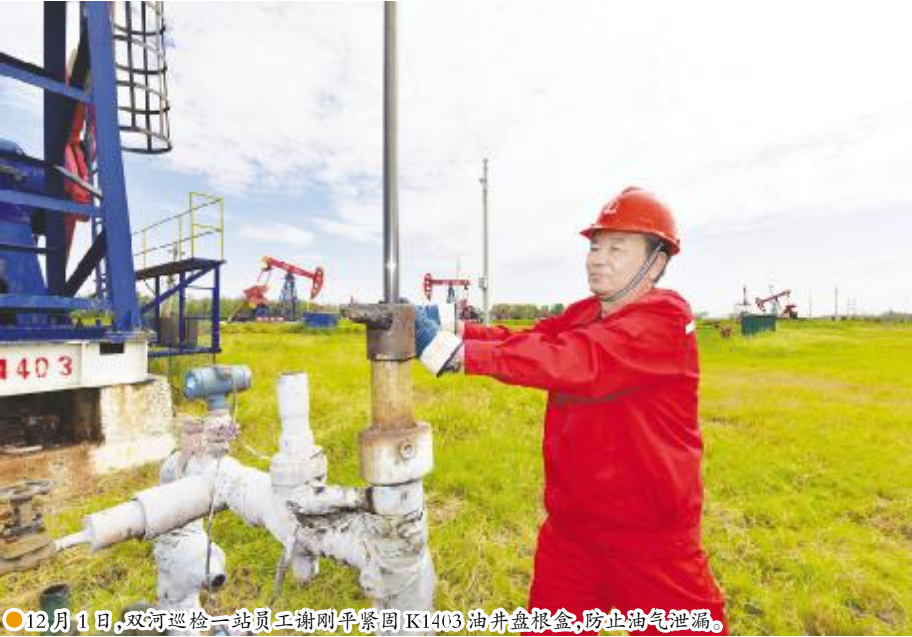
12月1日,双河巡检一站员工谢刚平紧固K1403油井盘根盒,防止油气泄漏。
