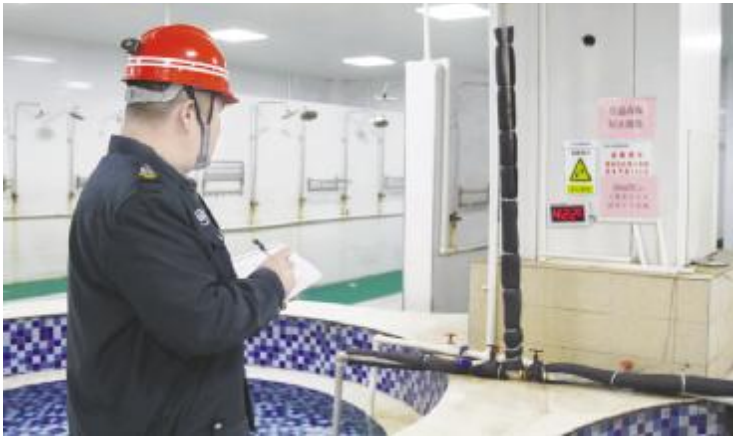
● 检查供热情况。
