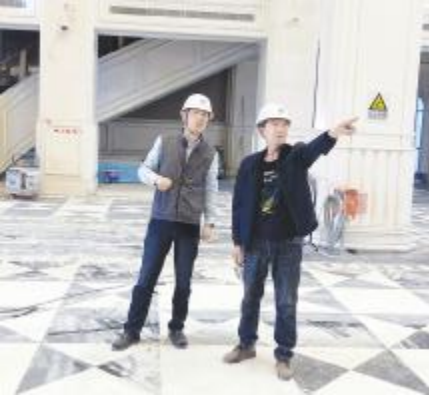
● 贾兆为在建筑装饰施工现场
