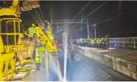
● 11 月 17 日凌晨，中铁建电气化局集团三公司员工，利用“天窗”时间，在秦沈客专进行接触网大修工程接触线落锚作业。（安振华 摄）
