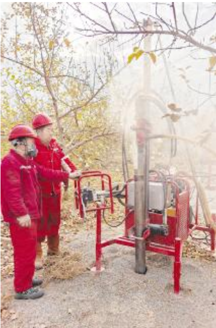
●采用跟管钻井工艺施工
