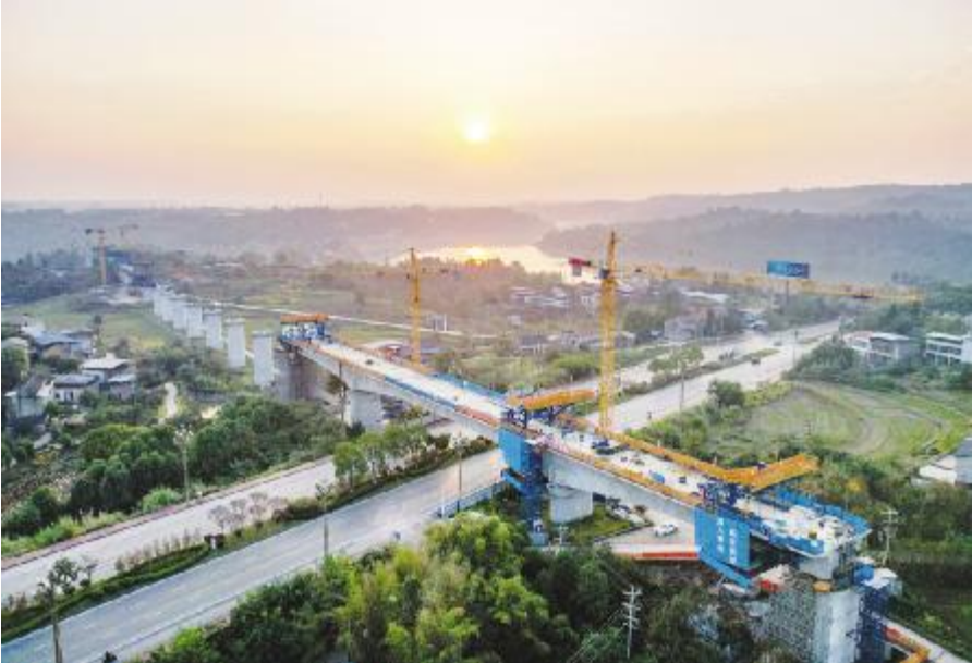
●正在建设中的西渝高铁四川省华蓥段清溪口特大桥。
