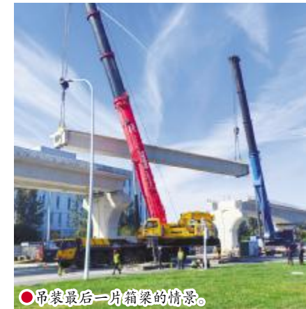
● 吊装最后一根箱梁的情景。
