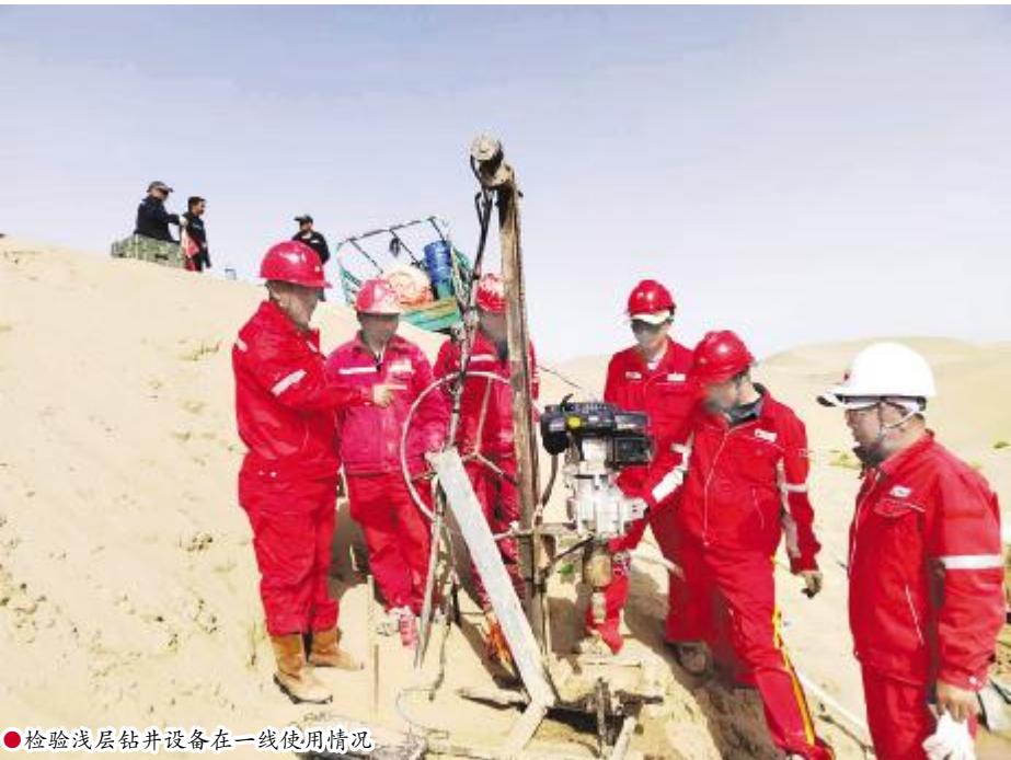
● 检验浅层钻井设备在一线使用情况
