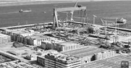
● 这是10月30日拍摄的海油工程天津智能制造基地(无人机照片)。
