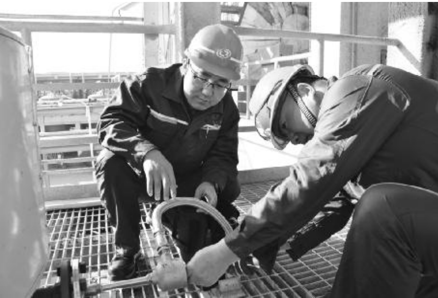
●党员在检修中
