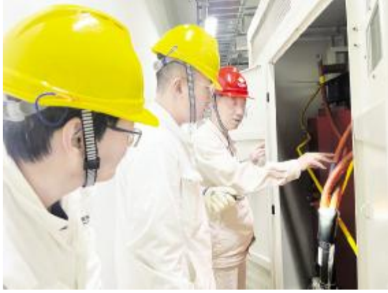
●图为电气主管向青年员工讲解变压器构造
