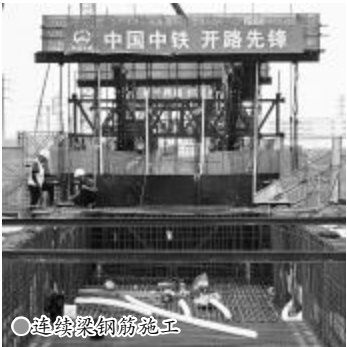
●连续梁钢筋绑扎工
