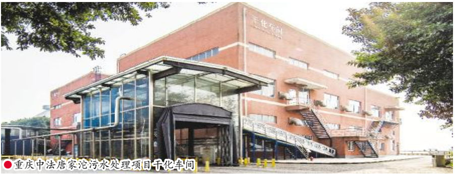
●重庆中法唐家沱污水处理项目干化车间
