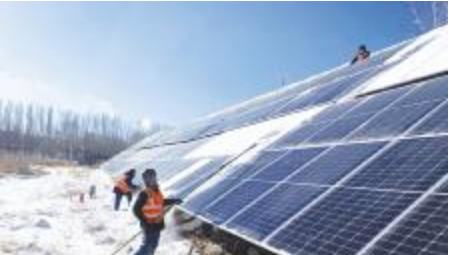
●2023 年 12 月 17 日,中铁建电气化局集团南方公司西北分公司赤大白铁路代维项目员工在赤水地检修工区光伏基地清理积雪。石攀登/摄
