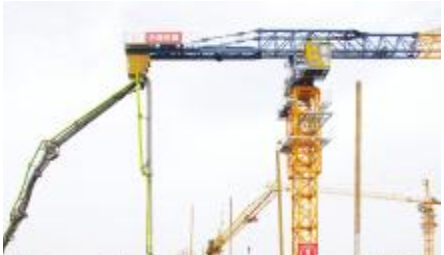
●2023 年 9 月 18 日,中铁建电气化局南方公司房建分公司员工,在武汉新城双碳产业园二期一号桥墩筑三层梁板一层墙挂混凝土。谢鹏/摄
