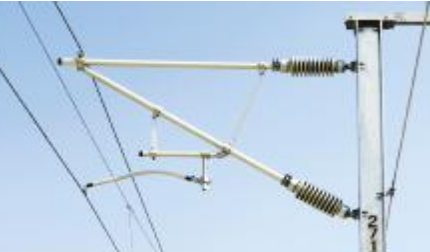
●2020 年 6 月 12 日在盐城(南)通高铁拍摄的已经安装好了的简化腕臂支撑及定位装置。时海洋/摄
