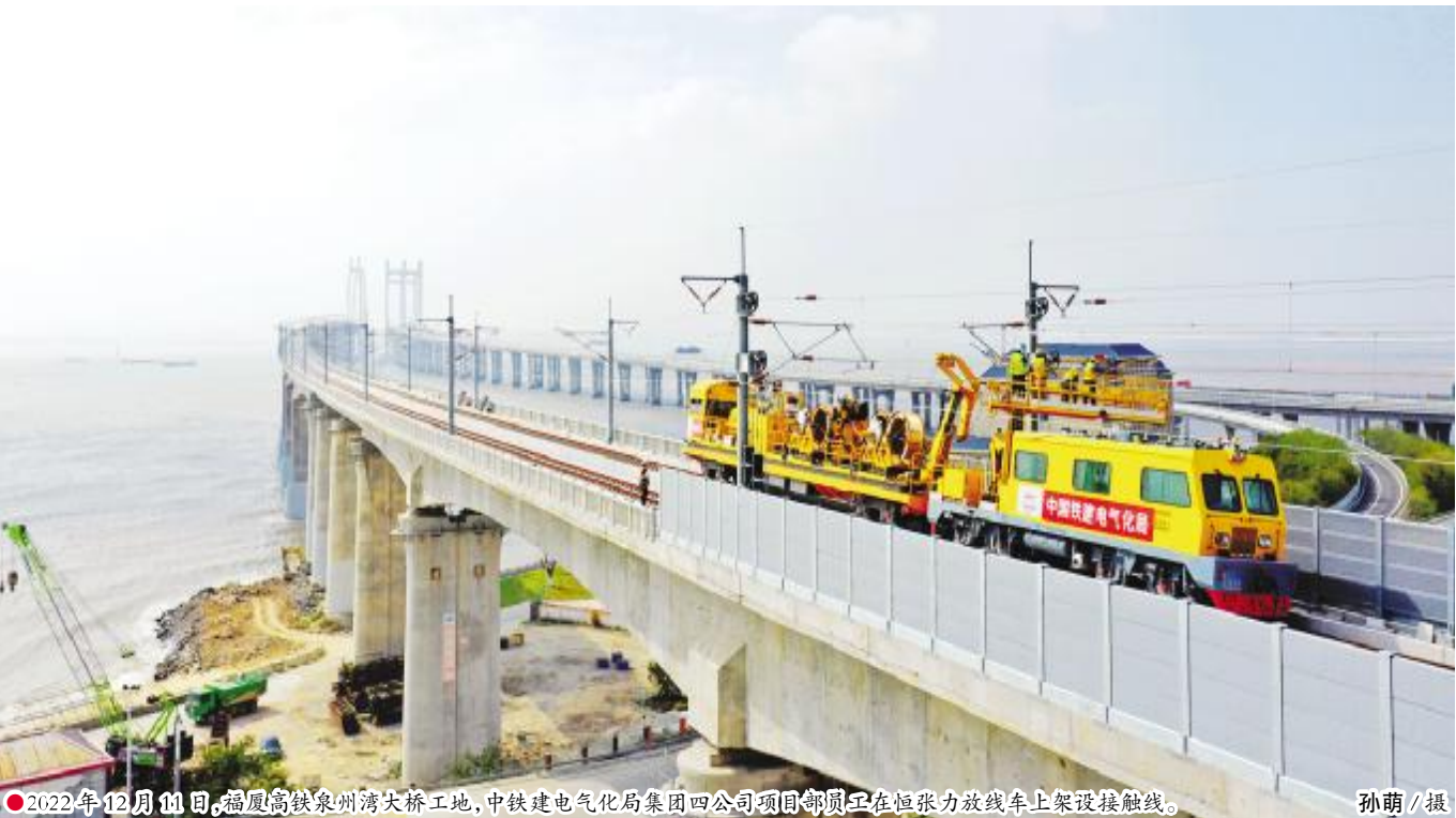
●2022 年 12 月 11 日,福厦高铁泉州湾大桥工地,中铁建电气化局集团四公司项目部员工在恒张力放线车上架设接触线。
