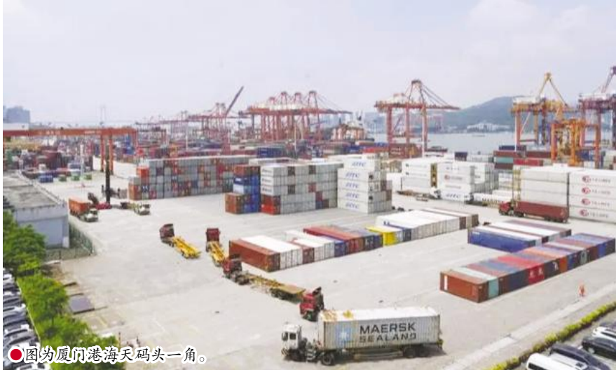
●图为厦门港海天码头一角。
