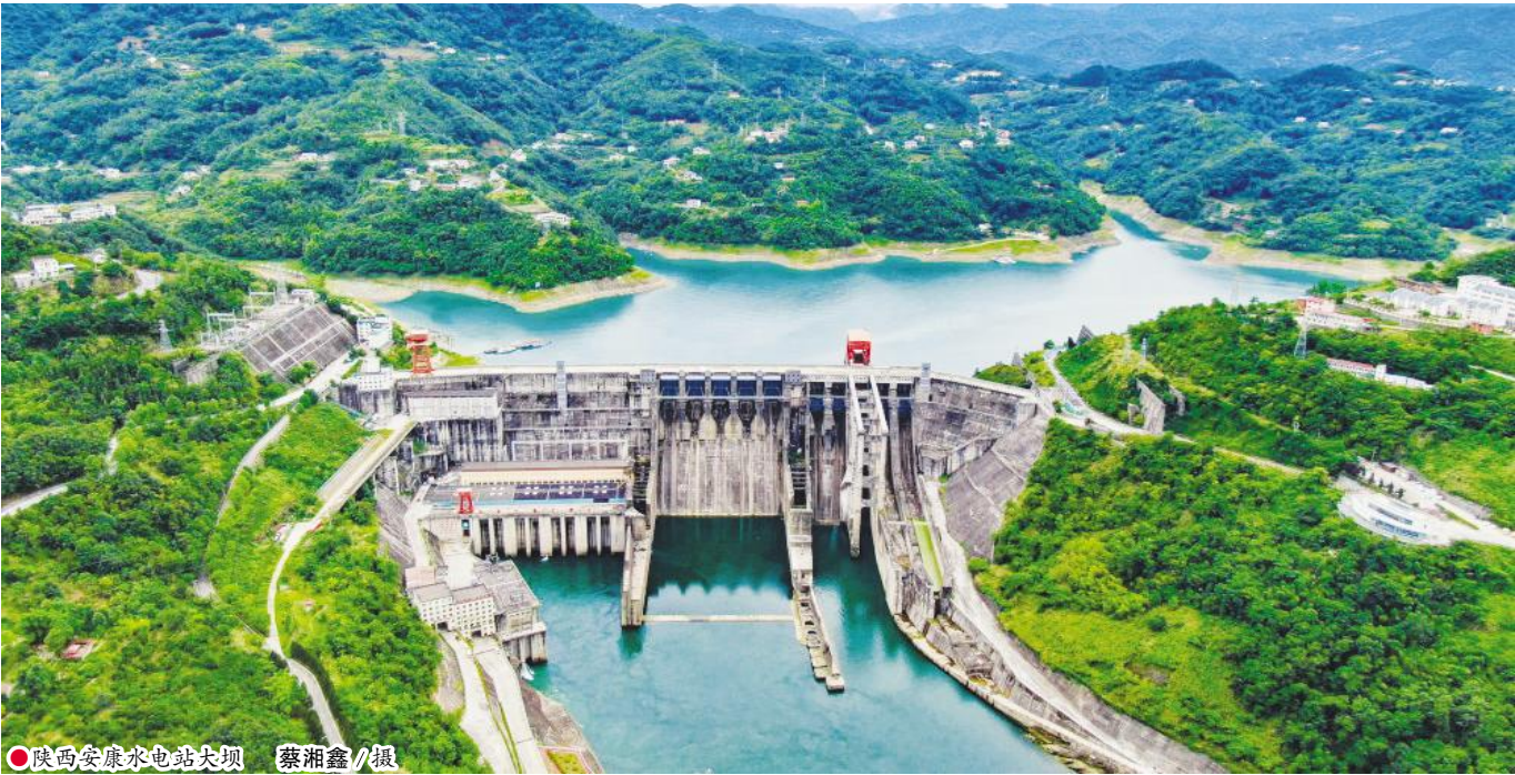
● 陕西安康水电站大坝 蔡湘鑫/摄
